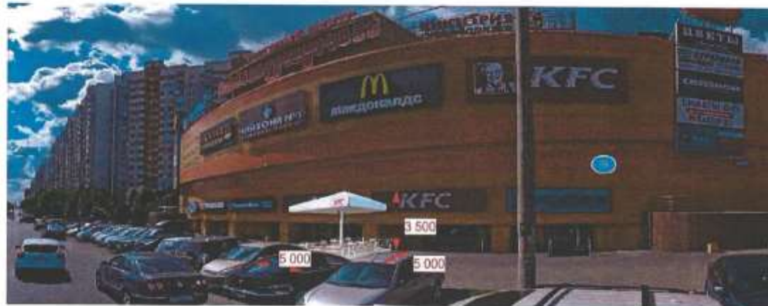
Общий вид здания с фото привязкой летнего кафе
